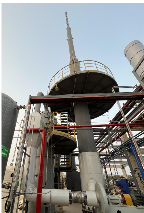
TO 焚烧炉废气排口
