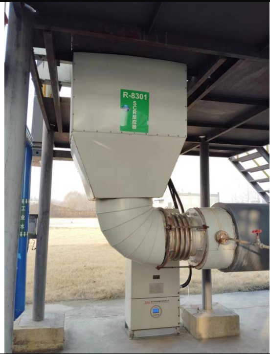
SCR 脱硝及二噁英吸附装置
