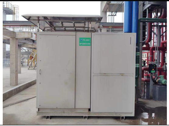
二氯甲烷冷凝
