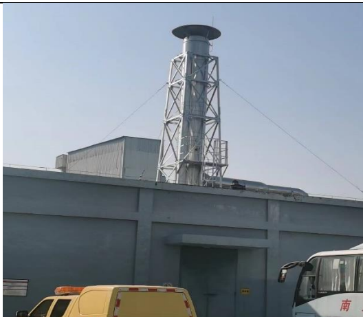
锅炉房排气筒
