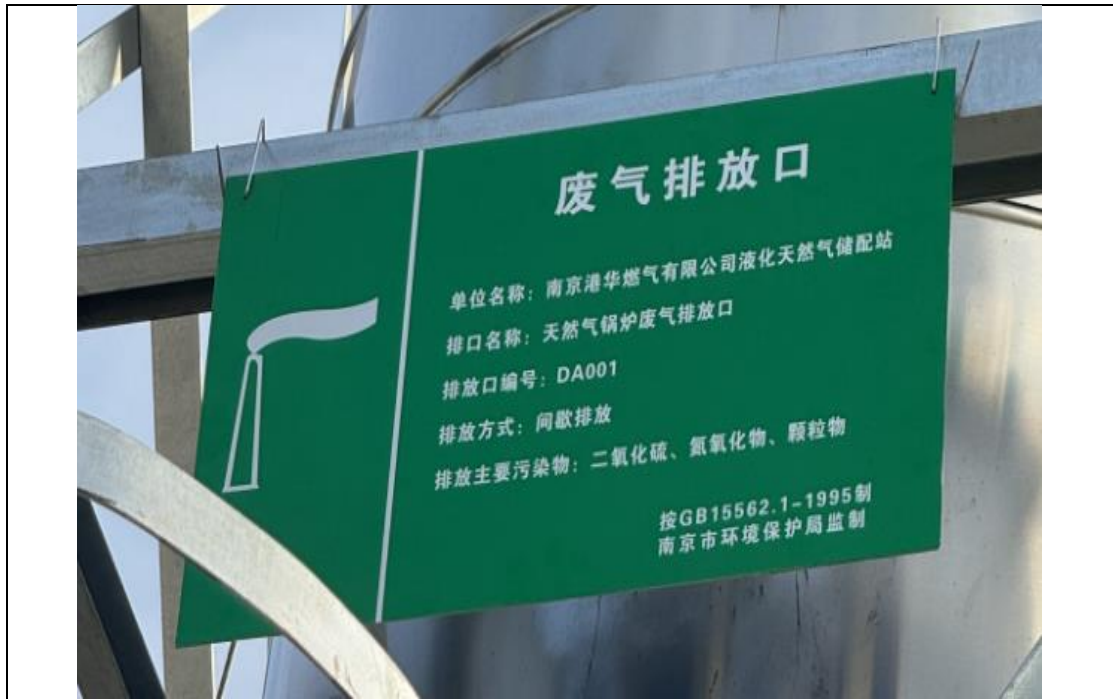
图 3-4 依托现有废气排气筒环保标识牌
