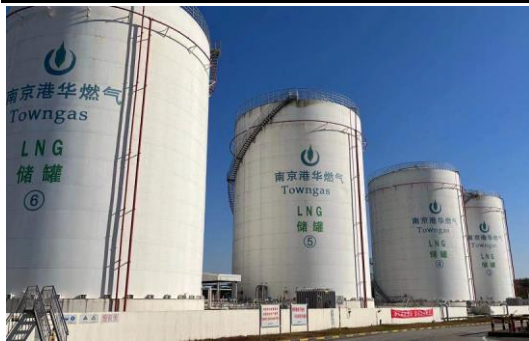
新建 LNG 储罐
